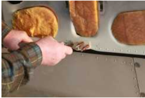
8. Installing Door Bracket
